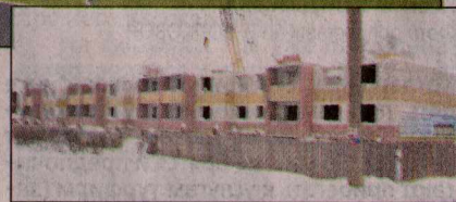
Строительство идет полным ходом.
