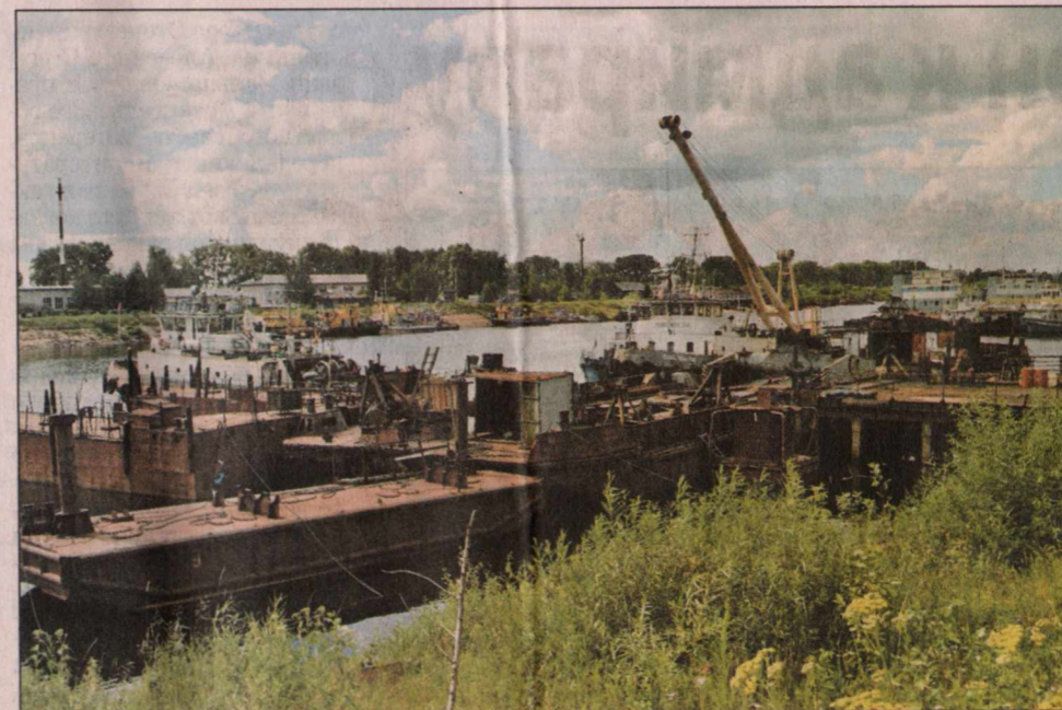
Летом на БОФ — текущие ремонты.
