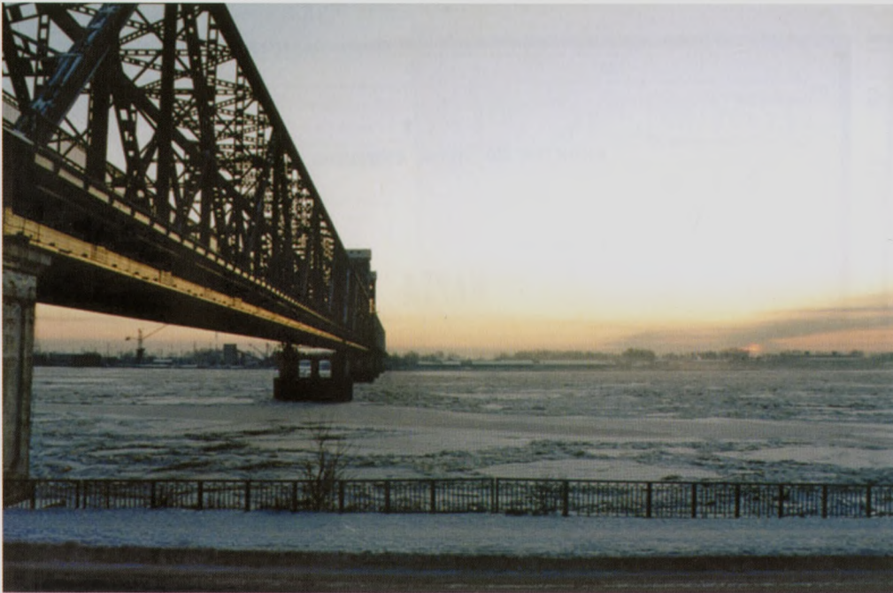
Мост через Северную Двину
