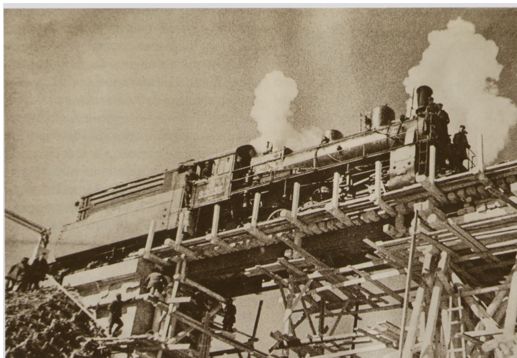
Первая установка поезда во время испытания моста
