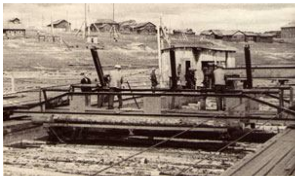
Первые мощные сплоточные станки в запани Дябрино.
