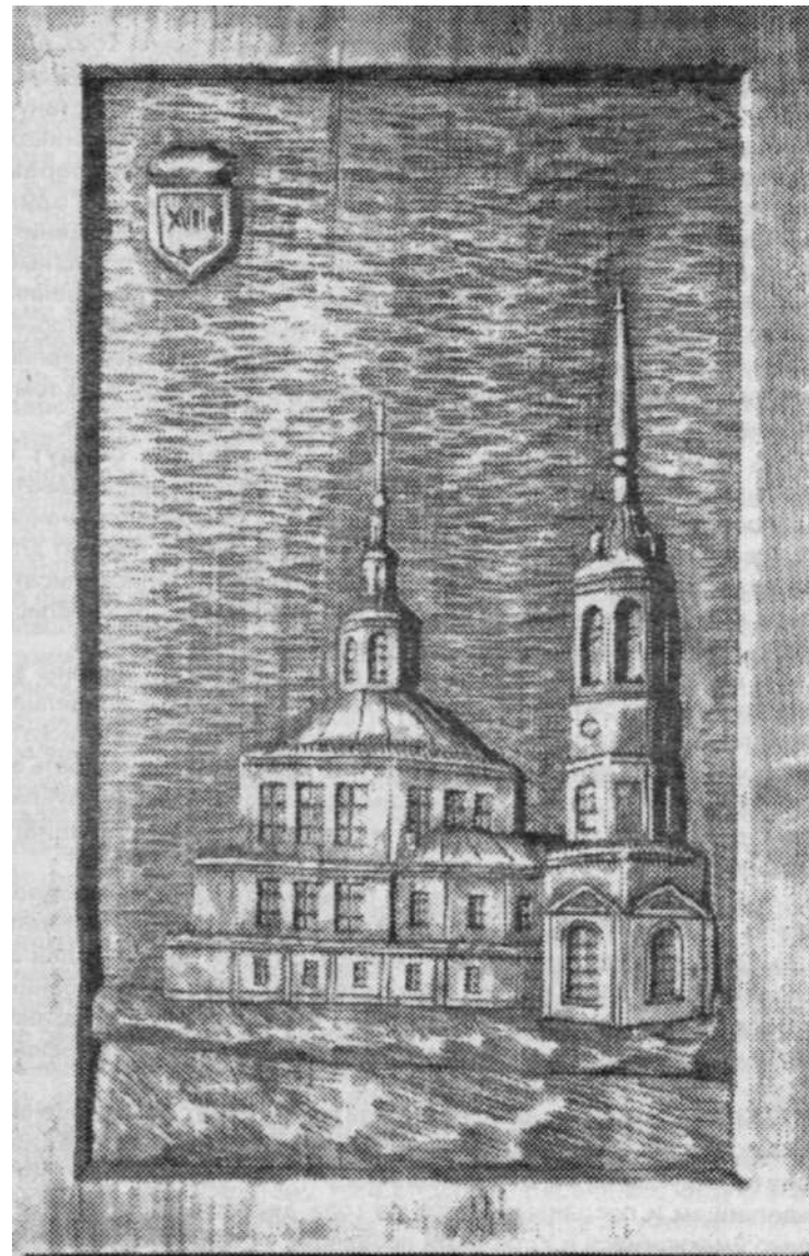
Борисо- Глебская церковь построена в 1757 году.
